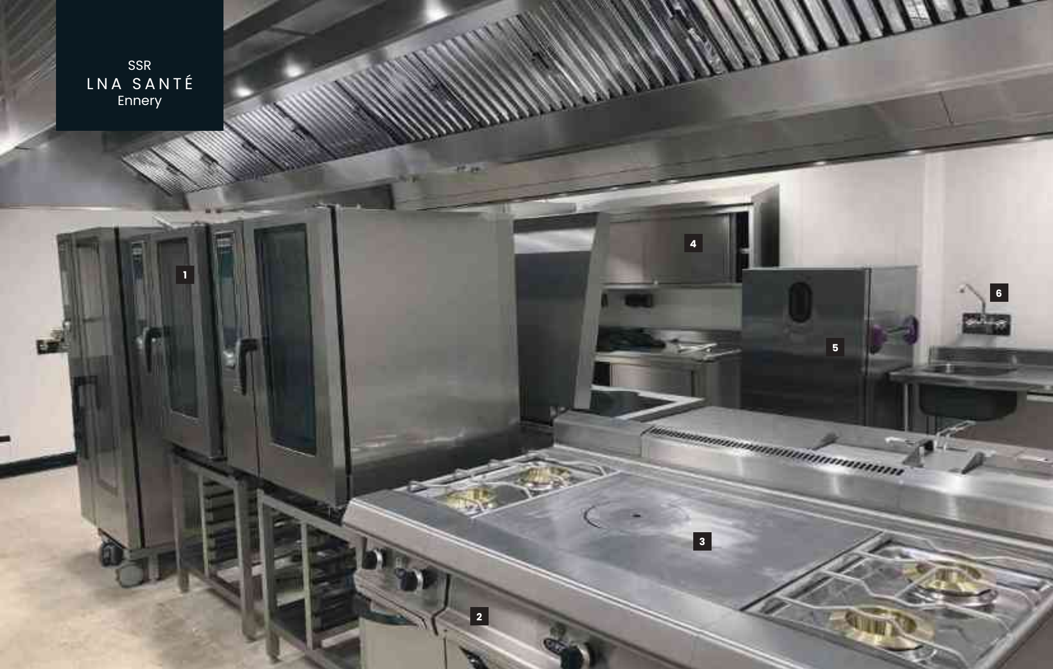
1 Four mixte RATIONAL (x3) 2 Fourneau gaz CAPIC 3 Fourneau 4 feux vifs + plaque coup de feu CAPIC 4 Inox BENARD INOX 5 Armoire de maintien en température BOURGEAT 6 Robinetterie murale MADIAL
