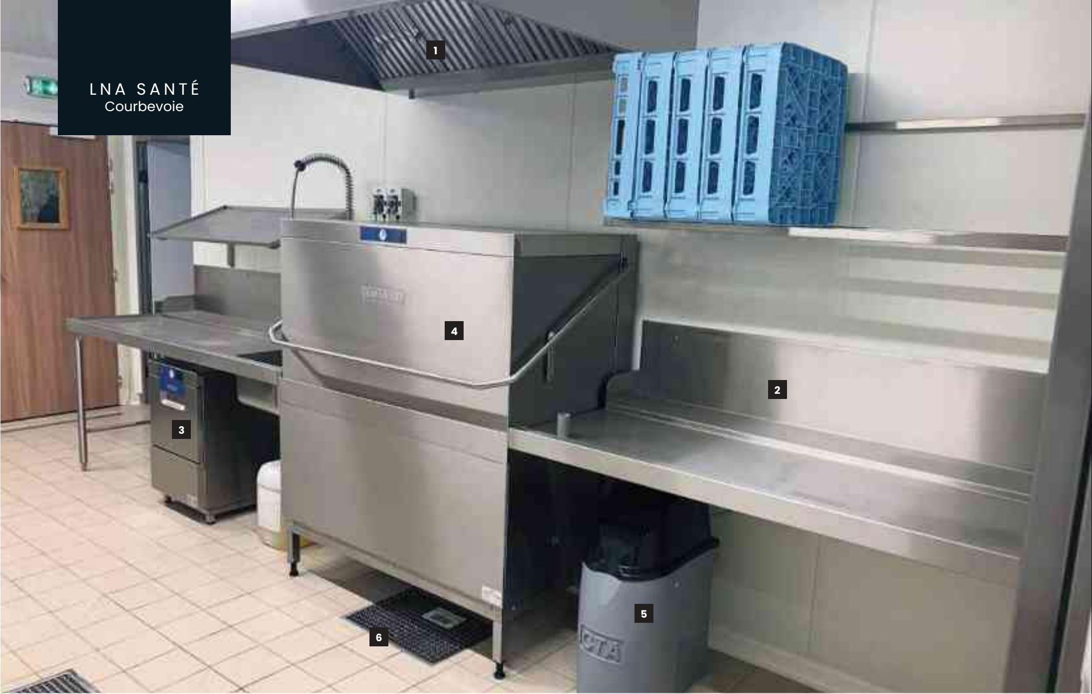
1 Hotte VMI 2 Inox sur mesure BENARD INOX 3 Lave verres frontal HOBART 4 Lave-vaisselle double capot HOBART 5 Adoucisseur eau froide CTA 6 Caniveau de sol ACO
