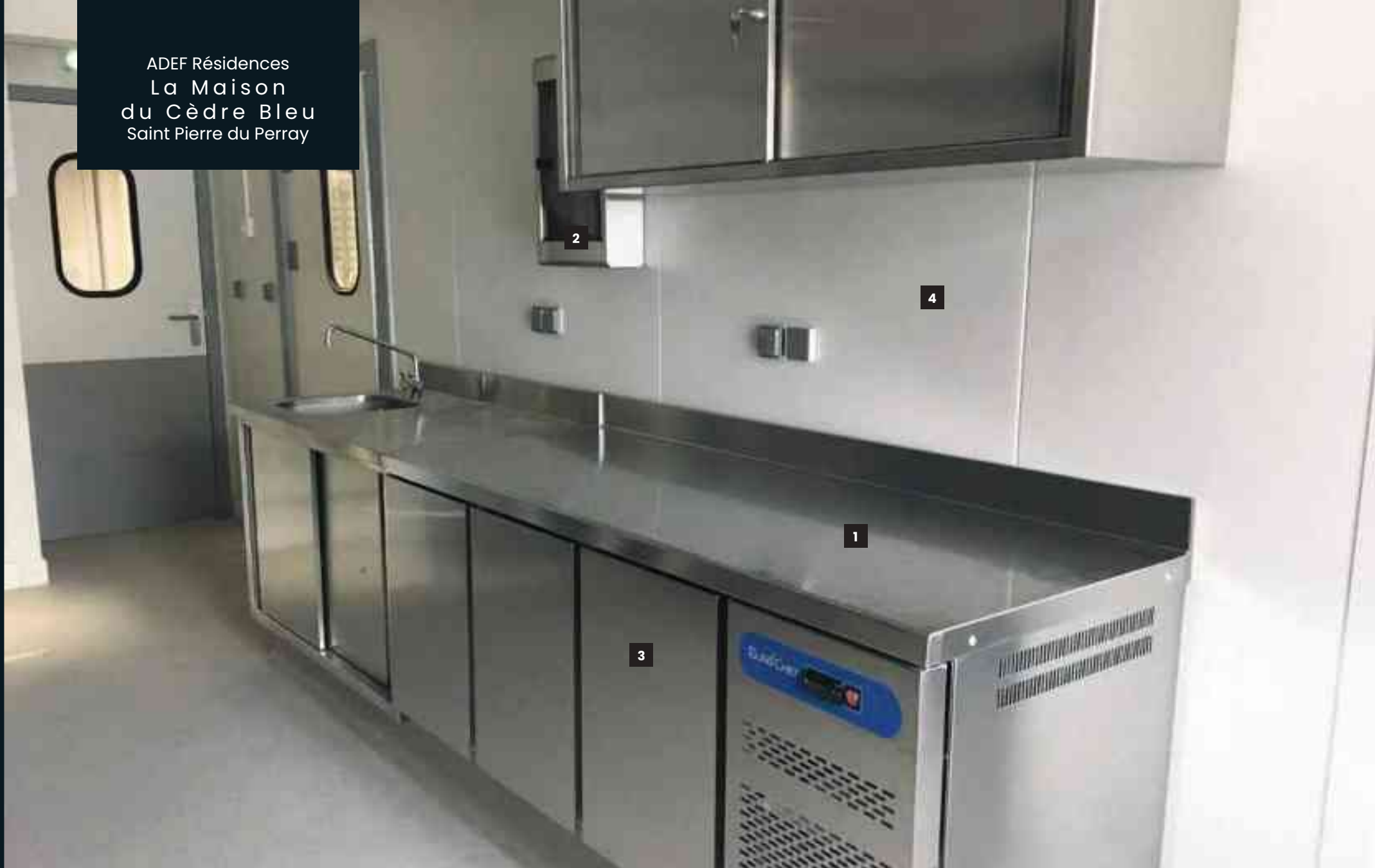
1 Inox GASTROPOLAND 2 Armoire à couteaux BRC 3 Meuble réfrigéré ASBER 4 Panneaux DAGARD
