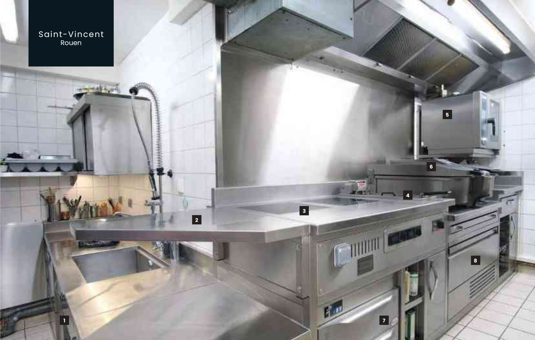
1 Lave-vaisselle frontal HOBART 2 Inox sur mesure ARTINOX 3 Foyer induction ADVENTYS (x2) 4 Friteuse FRIFRI 5 Four mixte RATIONAL 6 VCC 112T RATIONAL 7 Tiroirs chauffants ALTO-SHAAM 8 Tiroir réfrigéré FOSTER
