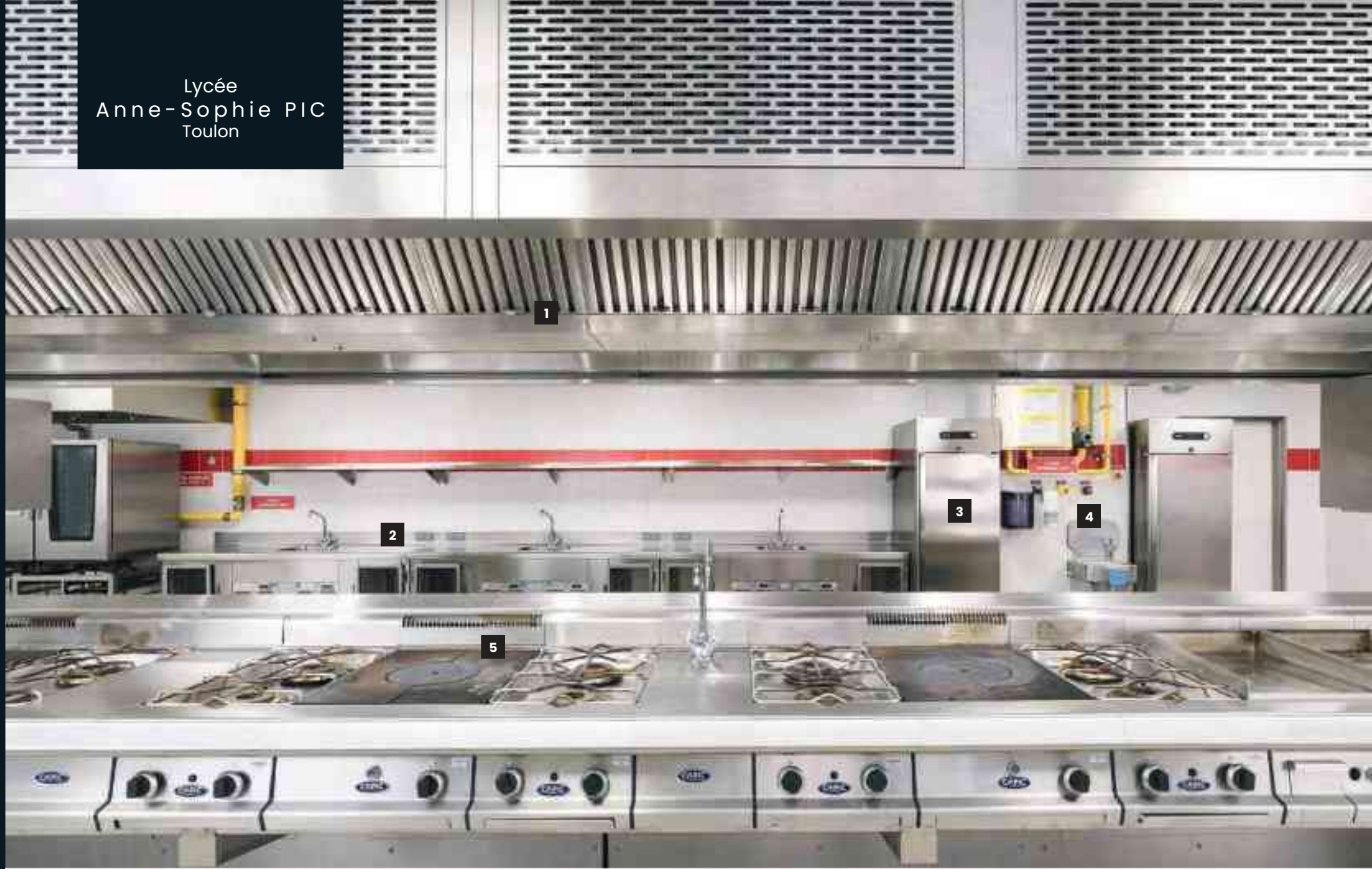
1 Plafond filtrant SAFTAIR 2 Plan de travail PYRENOX 3 Armoire réfrigérée HOSHIZAKI (x2) 4 Lave-mains TOURNUS 5 Ensemble cuisson avec feux vifs et plaques coup de feu CAPIC
